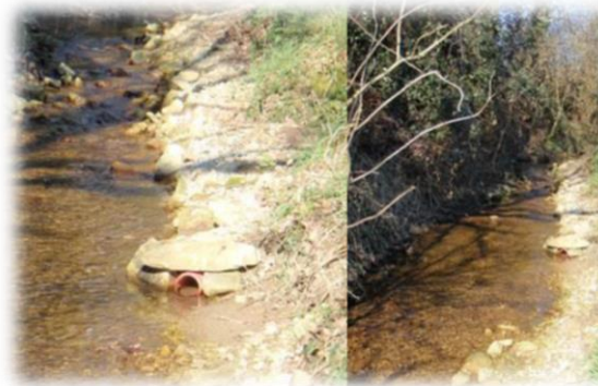
Rallongement d'un drain pour permettre sa sortie plus en aval (Pénerf, Syndicat Mixte du Golfe du Morbihan)
