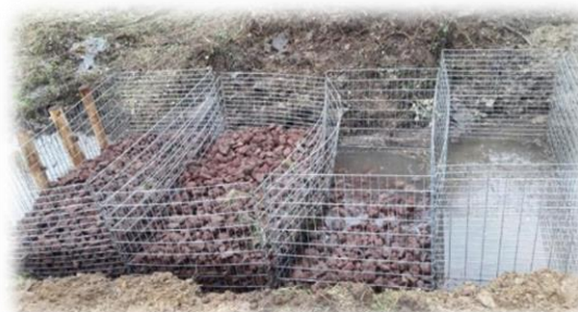
Photographies d'un dispositif filtrant à paille (gauche) ou à gabion (droite) en aval d'un chantier
