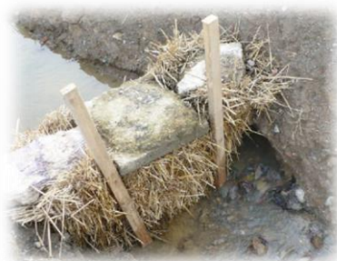
Photographies d'un dispositif filtrant à paille (gauche) ou à gabion (droite) en aval d'un chantier
